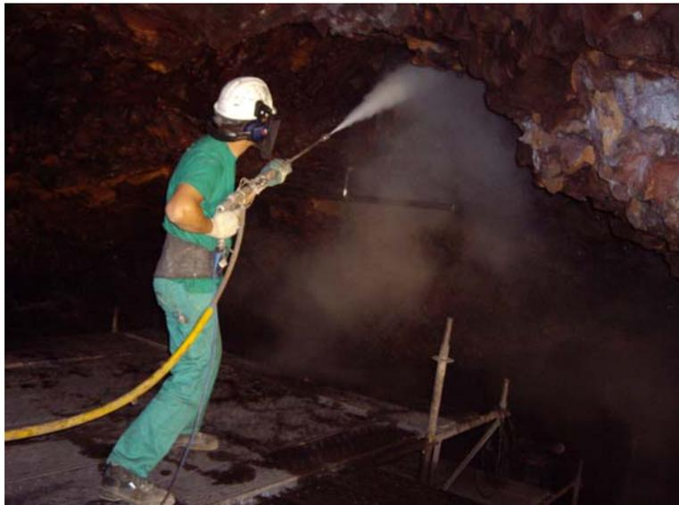
Fotografías 8 y 9: Hidrodemolición y lavado con agua a muy altas presiones
