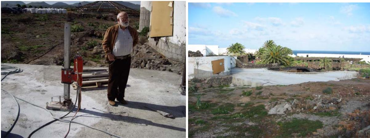
Fotografías 13 y 14: Perforadora posicionada para la ejecución de taladros desde el exterior en el estrato mejorado. Vista panorámica del estrato mejorado una vez terminado.
