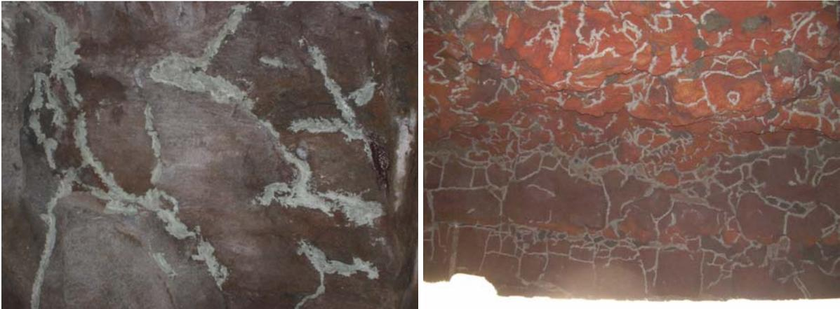
Fotografías 16 y 17: Cordones de soldadura química una vez colocados.
