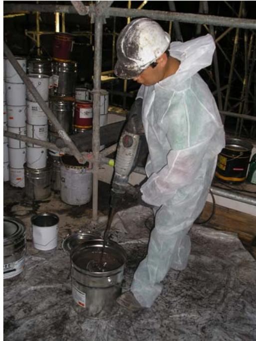
Fotografía 10: Fabricación de la resina epoxi de coloración predeterminada.
