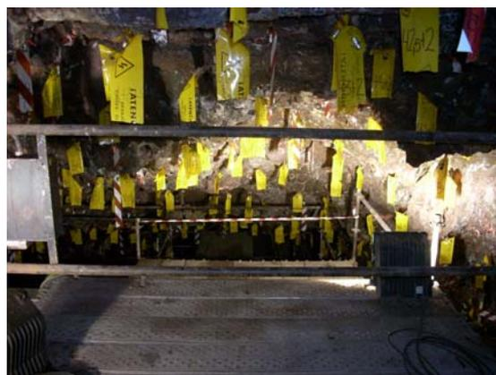
Fotografía 12: Clave del auditorium con identificación individualizada de bulones colocados.
